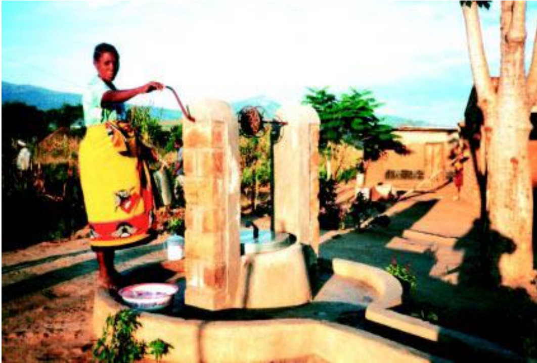
Figura 4.9 - Poço Familiar Melhorado com implementação de uma bomba manual em África (Fonte: Water and Sanitation Program, 2002)
