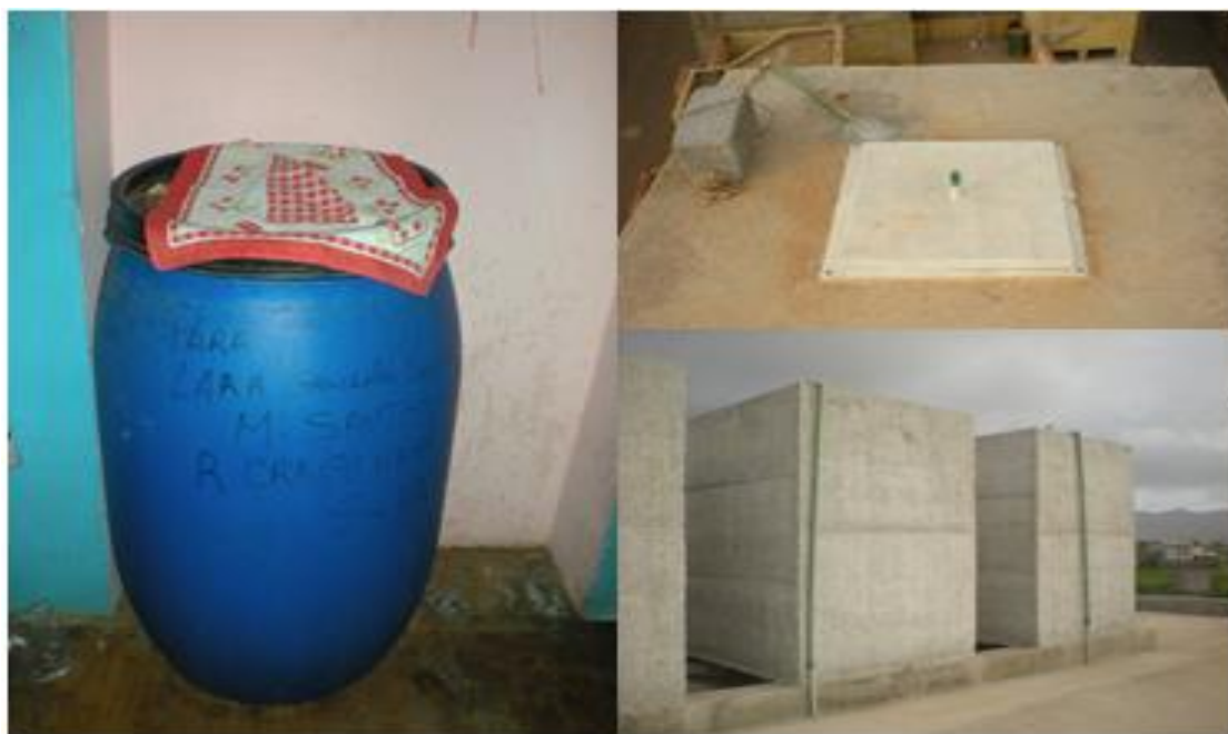
Figura 3.9 - Reservatórios domésticos, utilizados para armazenamento de água (Fotografias tiradas em Setembro de 2013, Cabo Verde)
